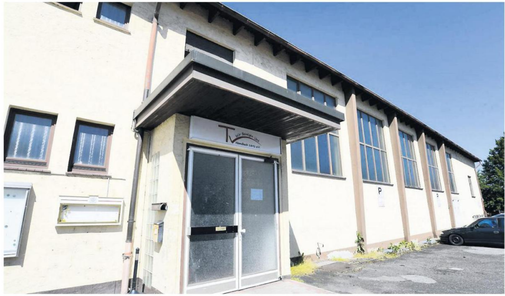
Der Hallenneubau ist für den TV Hemsbach gestorben. Auf einen Geländetausch mit der Stadt Hemsbach ließ sich der Verein nicht ein. Jetzt wird über die Sanierung des Hallendachs nachgedacht. BILD: THOMAS RITTELMANN
